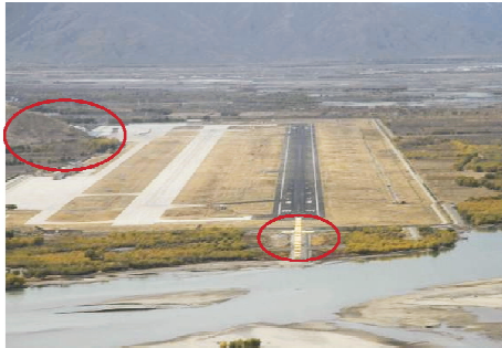
(a) 拉萨机场真实照片
