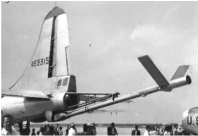
图 1 第一代硬式空中加油机(KB-29P)
