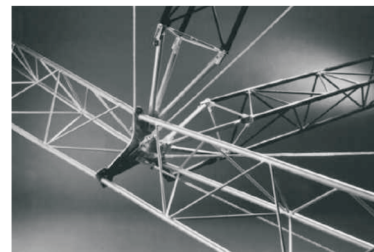
图 10 三角形隔框和纵梁连接点 [6]
